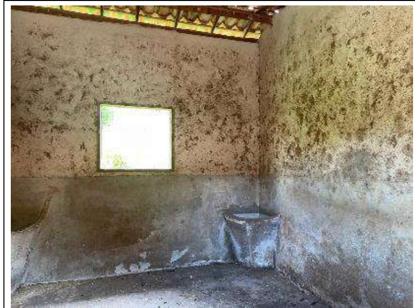
Baia – vista interna.
